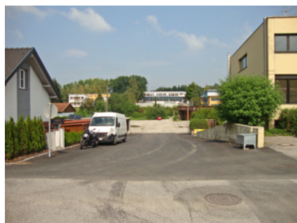
Auch der Schulsteig erhielt endlich eine neue Asphalttschicht
