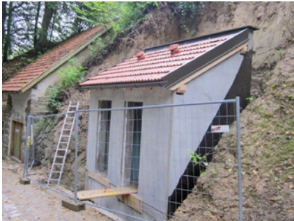
Die Arbeiten an der WC-Anlage in der Kellergröppe sind in vollem Gange
