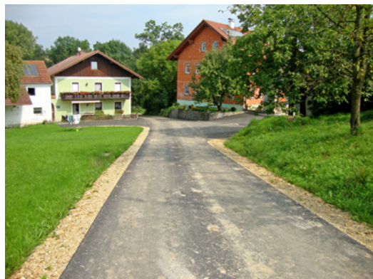
Ein Teilstück des GW Hochpireth wurde neu asphaltiert
