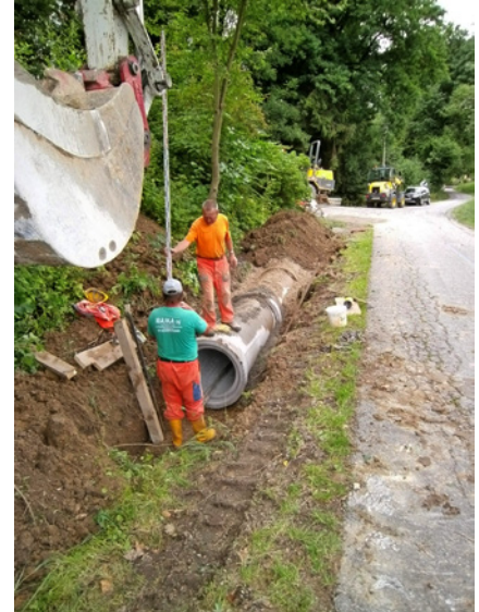
Aufgrund der Ableitung von Reinwässern des neuen Siedlungsgebietes Ahornweg über Hirschdobl musste der offene Graben in Hirschdobl verrohrt werden
