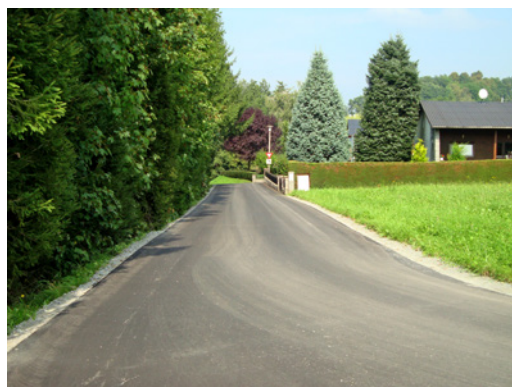
Ein Teil der Straße im Würmerfeld erhielt eine neue Asphaltdecke
