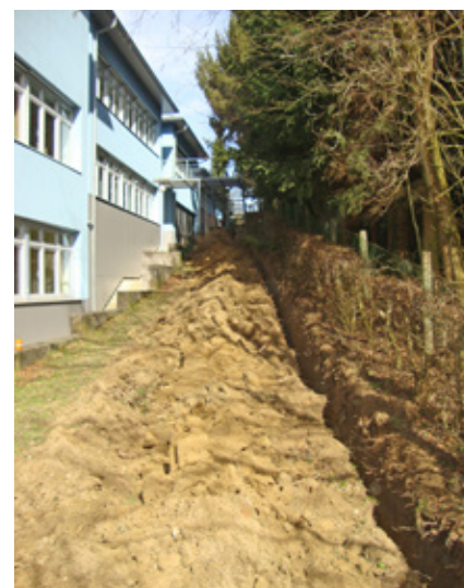
Entlang der Neuen Mittelschule waren Aufgrabungsarbeiten zur Verlegung des Glasfaserkabels nötig
