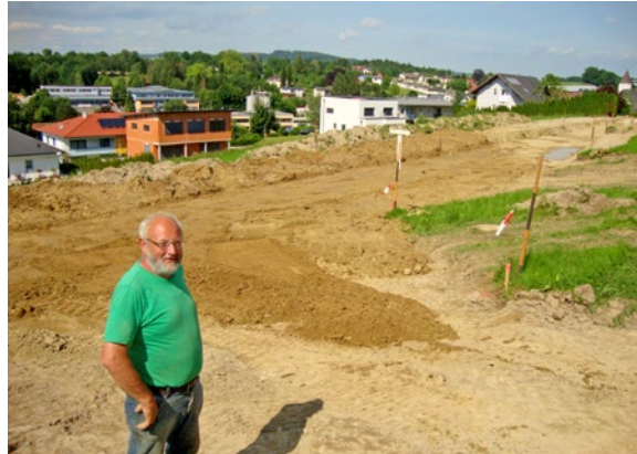
Bauhofvorarbeiter Johann Mayr auf einer seiner letzten Baustellen vor der Pensionierung – Am Etzlgrund
