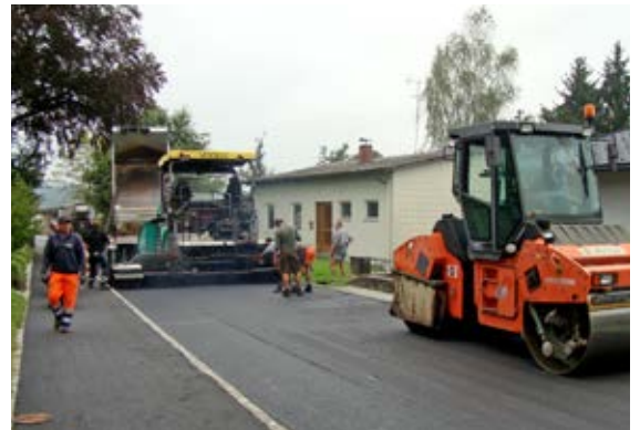
Zum Abschluss bekam die Schulstraße eine neue Asphaltdecke
