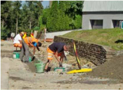
Arbeiter der Straßenmeisterei beim Setzen von Randleisten in der Schulstraße
