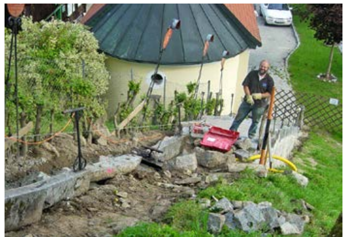
Bründlstiege während der Sanierungsarbeiten (2004)
