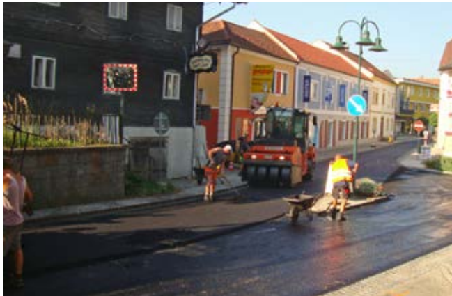
In der Marktstraße wurde von der Sparkasse bis zum Lagerhaus Pilstl eine neue Asphaltdecke aufgetragen
