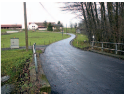
Der neu asphaltierte Güterweg Wetzlbach
