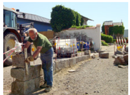
Eine Mauer wird beim Ausgang im oberen Bereich von Bauhofvorarbeiter Johann Mayr errichtet
