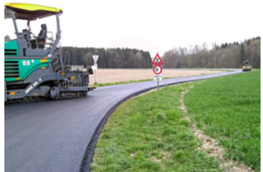
Der Güterweg Hochpireth erhielt eine neue Asphaltdecke
