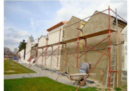
Die Rückseite der Wandgräber entlang des Urnenhains wurden saniert
