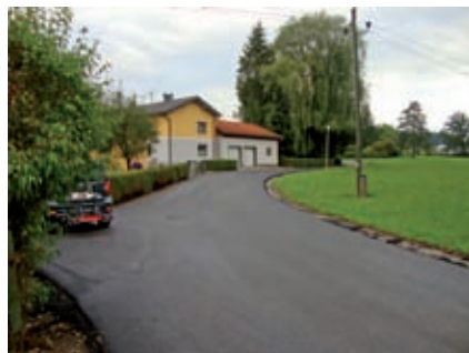
Auch die Gemeindestraße Moarhof erhielt einen neuen Belag
