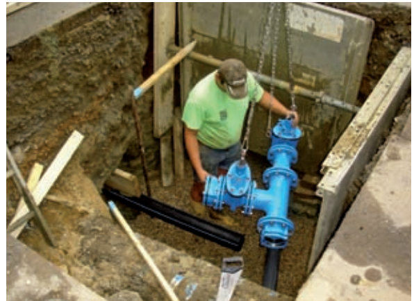
Anschluss der neuen Leitung an den Bestand
