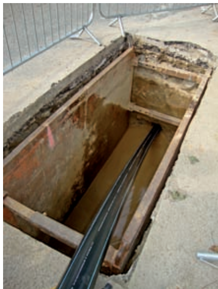
Einziehen der neuen Wasserleitung in die mittels Spülbohrverfahren hergestellte neue Leitungstrasse
