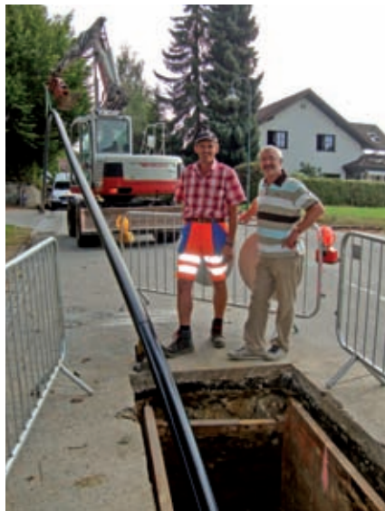
Einziehen der neuen Wasserleitung in die mittels Spülbohrverfahren hergestellte neue Leitungstrasse
