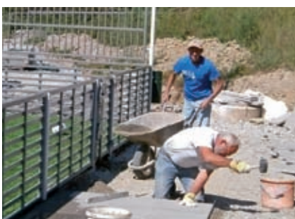
Bauhofvorarbeiter Johann Mayr und Aushilfskraft Heinz Furthner beim Verlegen der Umrangungsplatten
