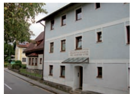
Das Mitte der 1980er Jahre sanierte Wohnhaus der Gemeinde Hauptstraße 3
