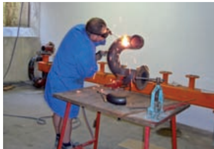
Martin Seidl, Firma Zweimüller, bei Arbeiten an der Heizung
