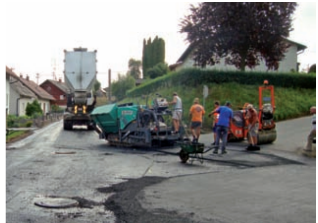
Die Firma Swietelsky bei den Asphaltierungsarbeiten in der Pausinger Straße
