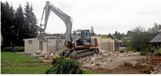
Beim Abbruch der alten Umkleide ...
