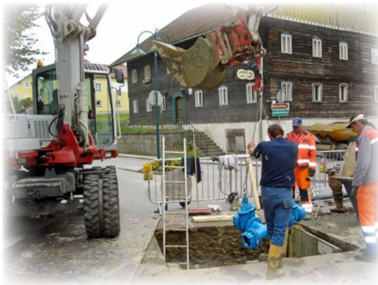
Sanierung der Wasserleitung in der Marktstraße
