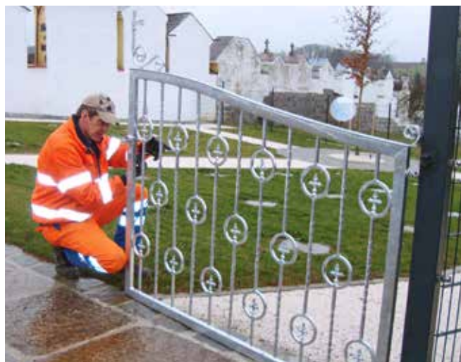
Bauhofmitarbeiter Manfred Lehner bei der Montage des von ihm gefertigten Zufahrtstores beim Urnenhain
