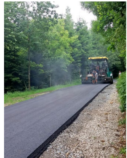
Asphaltierung des Güterweges Rotmayrberg
