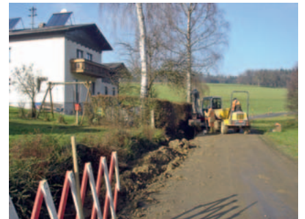
Der Kanalbau in Billingsedt ...
