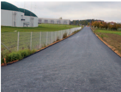
Die fertiggestellte Moarhofstraße mit Blick Richtung Gründerzentrum
