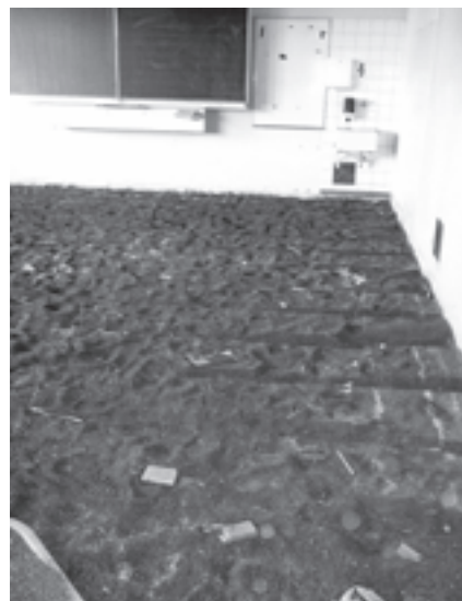
Als Sofortmaßnahme wurde der gesamte Bodenaufbau im Werkraum entfernt, der die größte Geruchsbelastung aufwies
