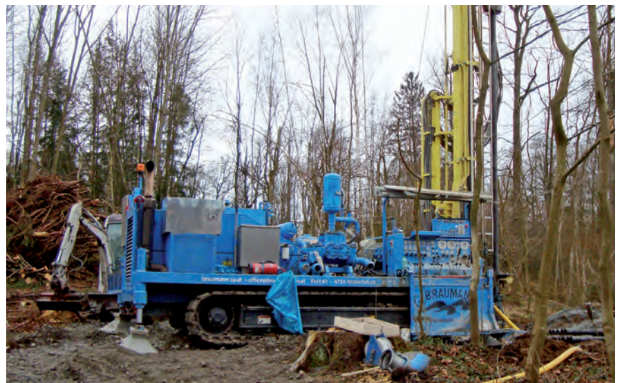
Erkundungsbohrung für die Errichtung eines zweiten Brunnens in Bründl
