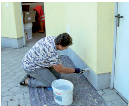
Maria Radlmair beim Streichen der Außenfassade
