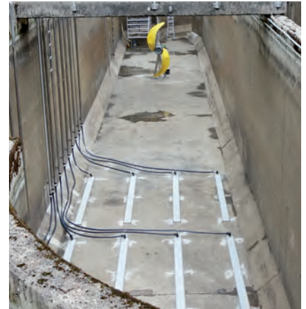
Die neu angebrachten Belüfter im Belebungsbecken
