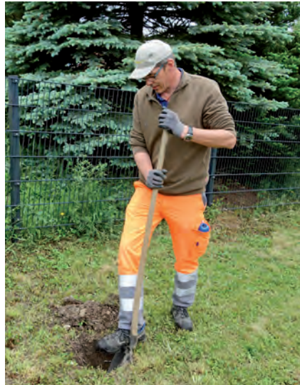
Wasserwart Manfred Lehner beim Freilegen eines Hausanschlussschiebers
