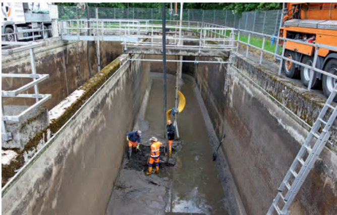
Die Reinigung des Belebungsbeckens durch die Bauhofmitarbeiter und das Raaber Unternehmen Maier-Bauer
