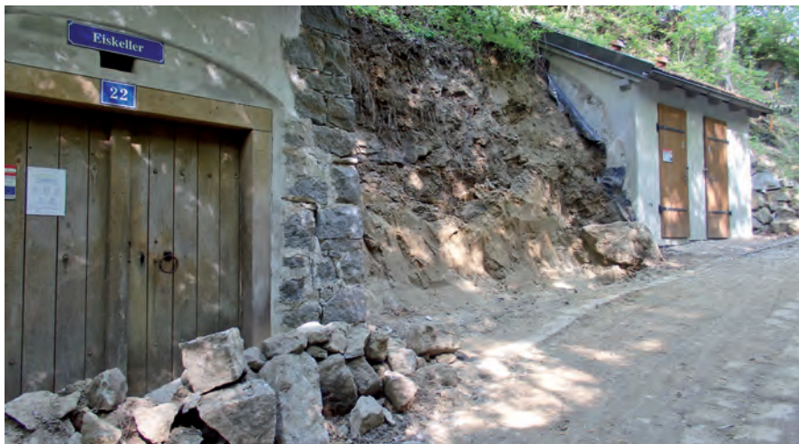
Im Mai wurde in der Kellergröppe eine einsturzgefährdete Mauer saniert
