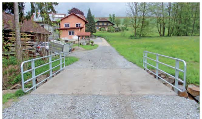
... wurde durch den Gewässerbezirk Grieskirchen umgesetzt
