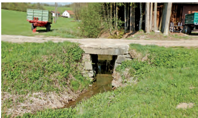
Die Neuerrichtung der Wirtschaftsbrücke in Wetzlbach ...
