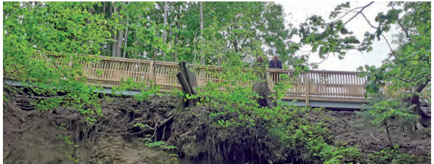
So sieht sie aus – die neue Brücke in der Zeller Gröppe
