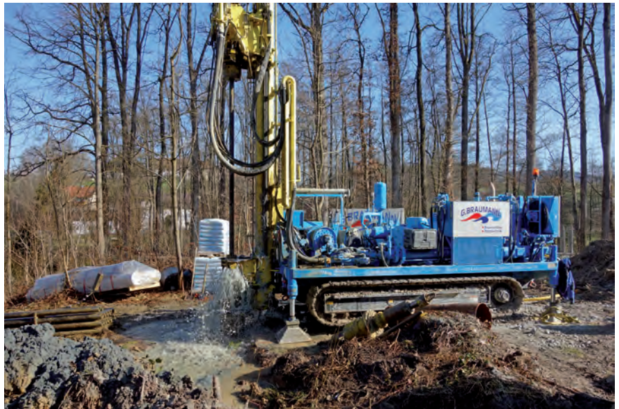
Aufbohrung des neuen Brunnens auf die geplante Größe
