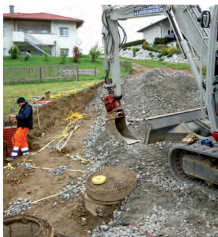
Das Teilstück zwischen Hirschdobl und Ahornweg wurde vom Bauhof ausgebaut
