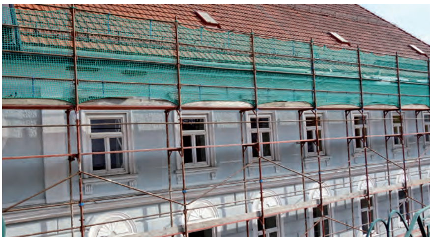
Die Sanierung wurde im Frühjahr 2021 durchgeführt
