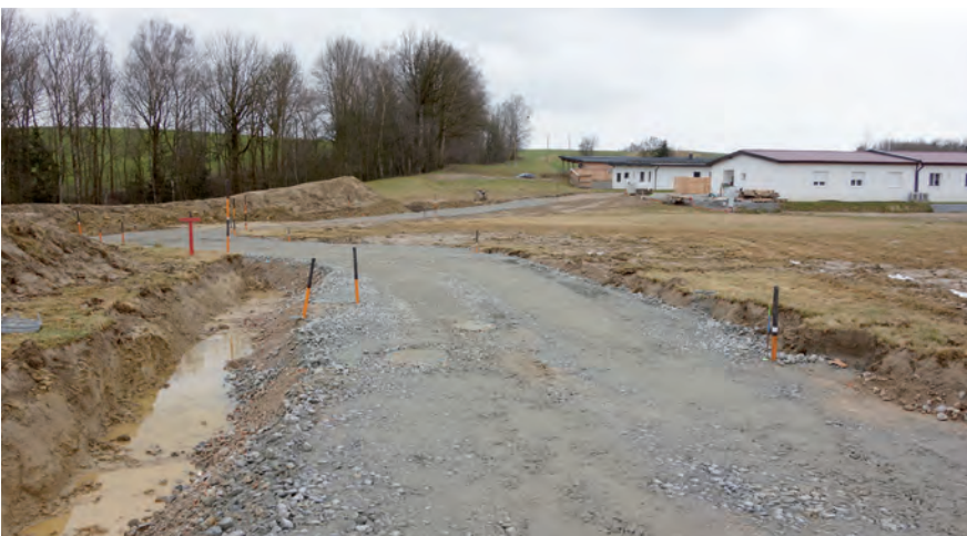
Die Arbeiten rund um den Straßenbau "Am Etlgrund" wurden im März begonnen
