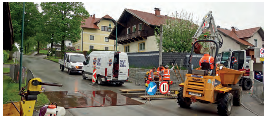
Wasserleitungsbauarbeiten im Bereich Bründlallee/Sonnenhöhe
