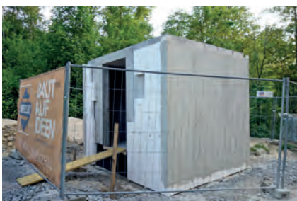
Der Rohbau des neuen Brunnenhauses
