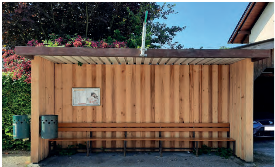
Das Buswartehaus am Kommuneplatz nach der Instandsetzung durch den Bauhof
