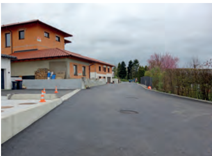
Nach der Fertigstellung der Asphaltierungsarbeiten
