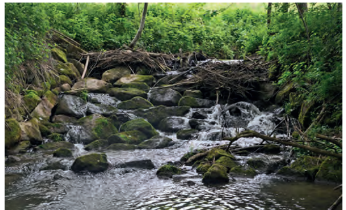
Ein unüberwindbares Hindernis für Fische in Bründl
