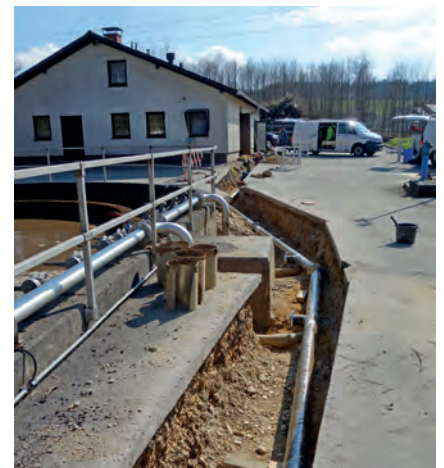
Die neuen, in Edelstahl ausgeführten, Luftleitungen
