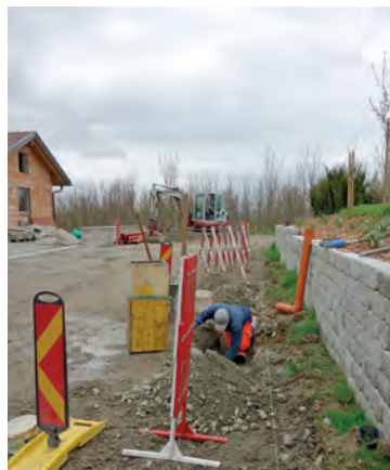
Herstellung der Entwässerung durch den Bauhof
