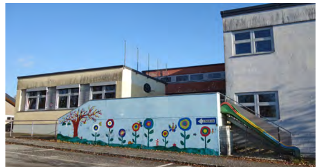
Auf die gesamte Fassade der Volksschule soll ein Vollwärmeschutz aufgebracht werden
