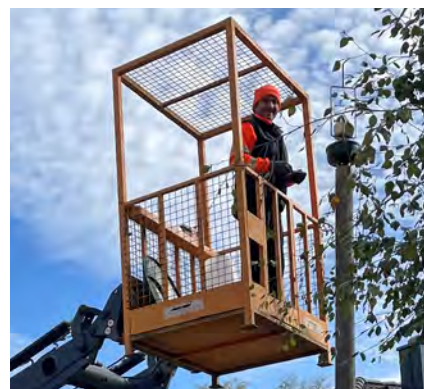
Bauhofmitarbeiter Günter Moser beim Umrüsten der Straßenbeleuchtung
