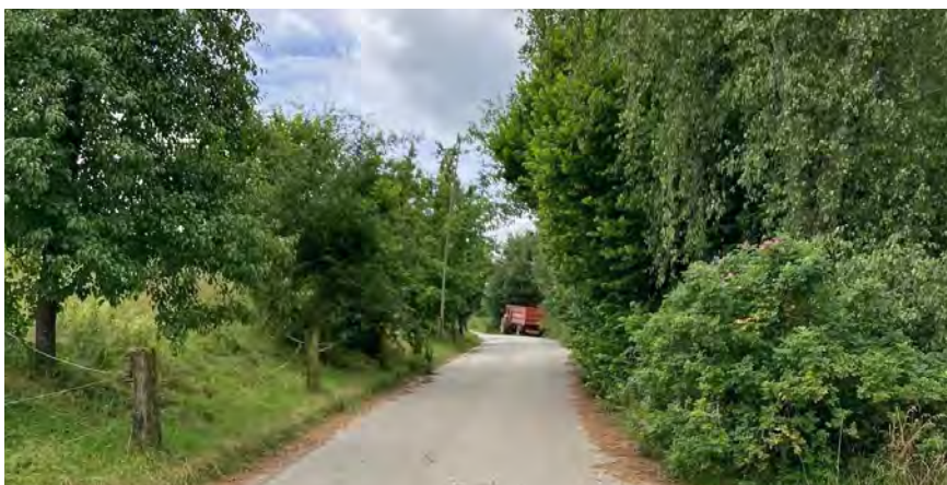
So bitte nicht - Lichtraumprofil muss freigehalten werden
