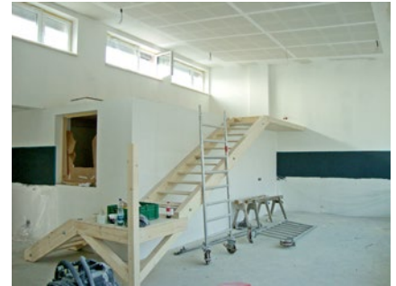
Im Obergeschoss entstand ein neuer Gruppenraum
