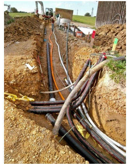
Acht verschiedene Leitungen wurden in der Straßentrasse verlegt
