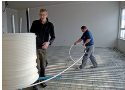
Verlegung der Fußbodenheizung im neuen Bewegungsraum
