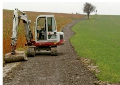
Der Wirtschaftsweg Gautzham wurde wieder instandgesetzt
