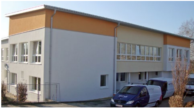
Das Kindergartengebäude erhielt ein neues Erscheinungsbild
