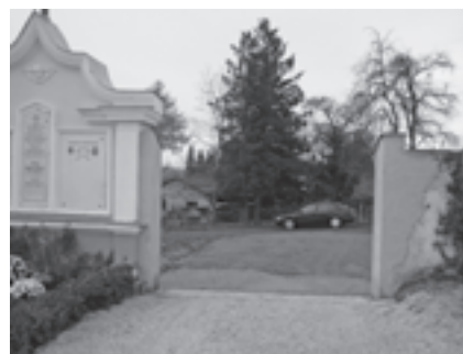
Die neu errichtete Zufahrt auf der Westseite des Friedhofs
