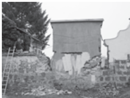
Durch den Abriss eines Wandgrabes konnte nun ein barrierefreier Zugang errichtet werden
